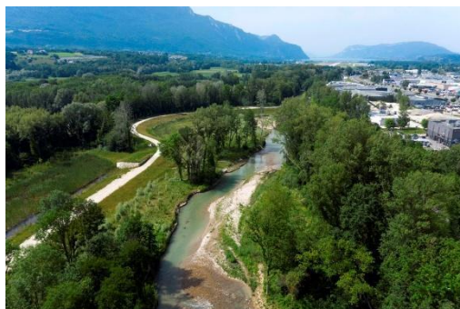
La Motte-Servolex / Zone d'extension des crues de la Leysse. © Photec pro
