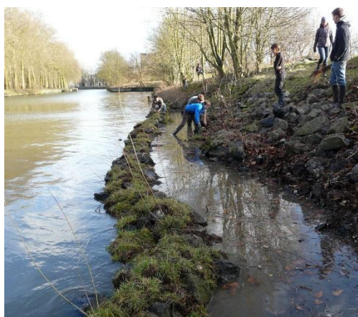
Lille / Renaturation de berge sur la Deûle.
